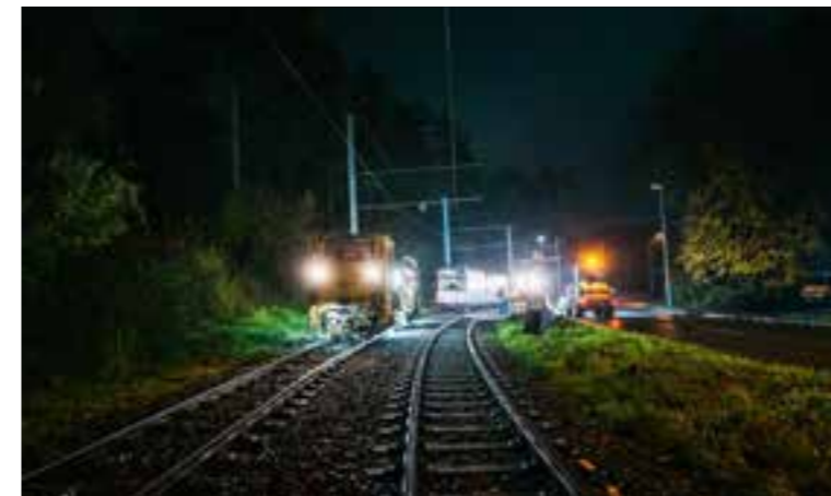
Gleisstopfarbeiten müssen meist nachts stattfinden, da sie den ÖPNV-Betrieb blockieren.
